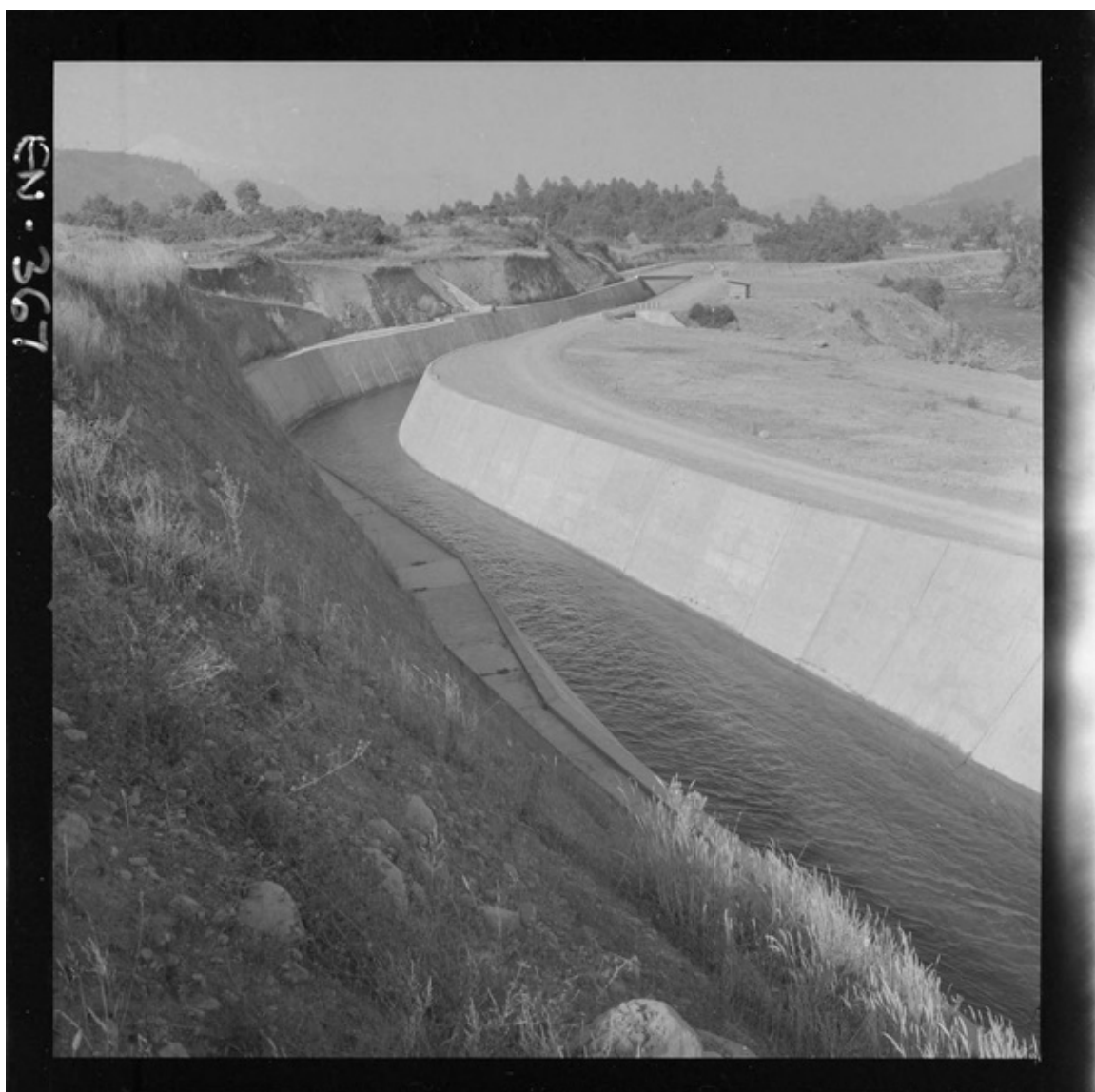
Canal de aducción [fotografía] Luis Ladrón de Guevara.
