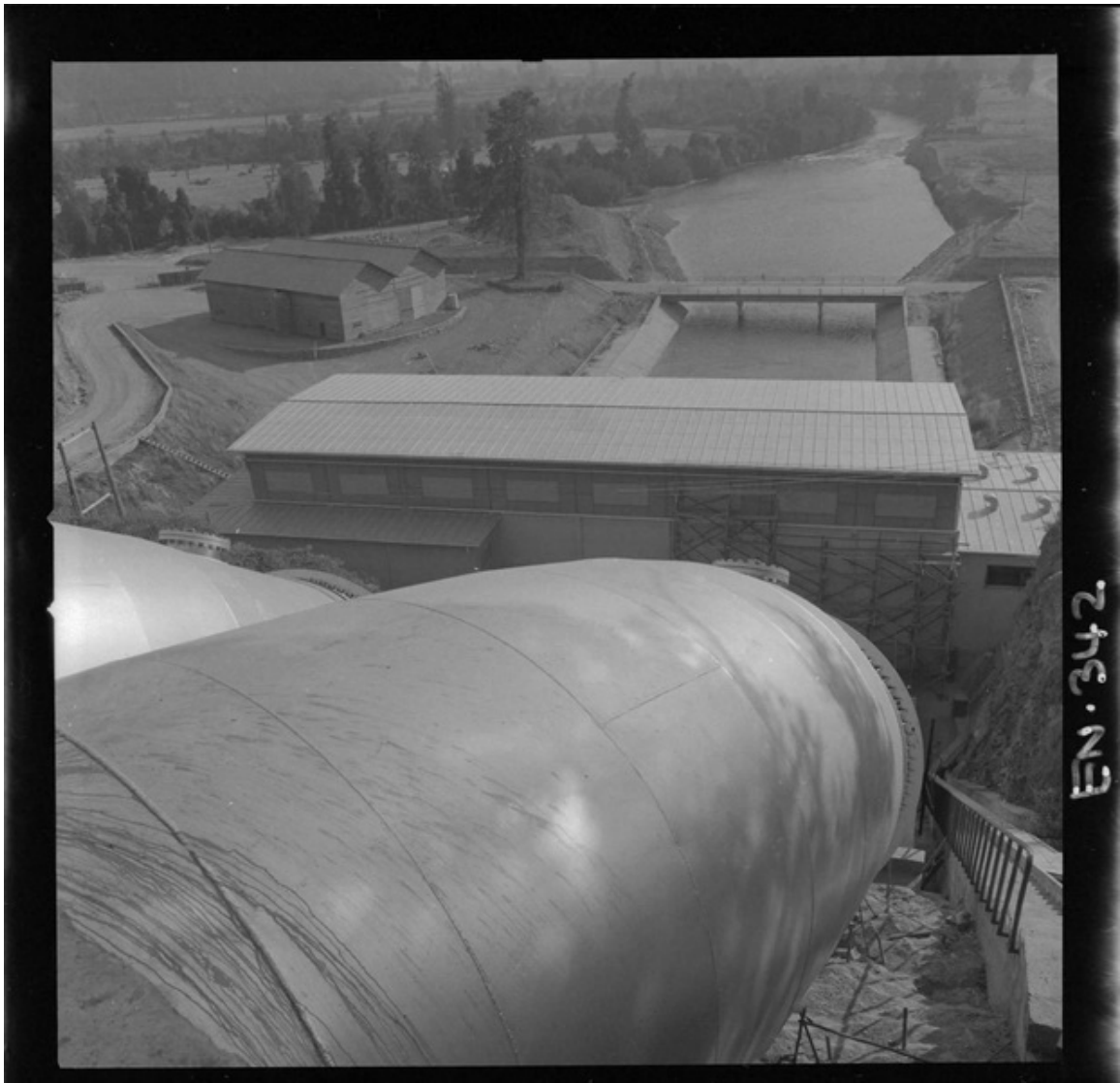
[Tuberías de acero construidas por CAP : 3,60 m. de diámetro y 80 m. de longitud] [fotografía] Luis Ladrón de Guevara.
