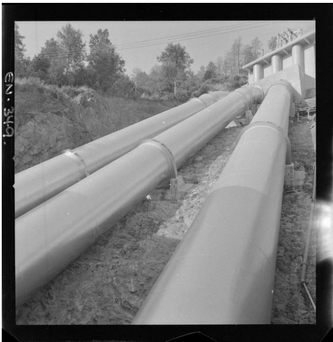
[Tuberías de acero construidas por CAP : 3,60 m. de diámetro y 80 m. de longitud] [fotografía] Luis Ladrón de Guevara.
