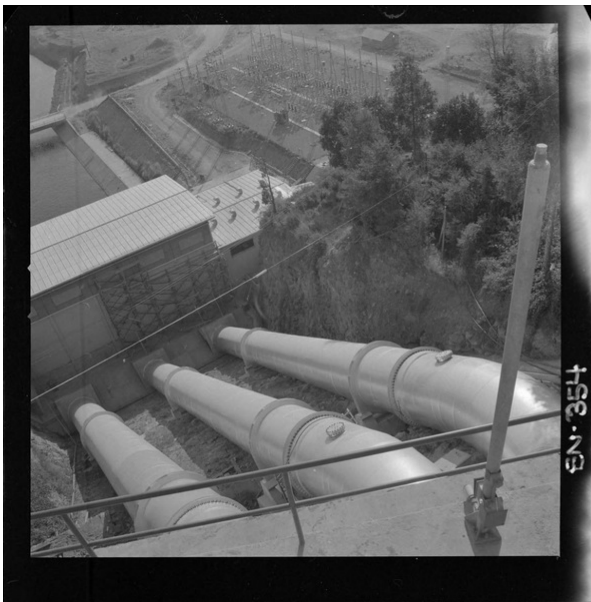
[Tuberías de acero construidas por CAP : 3,60 m. de diámetro y 80 m. de longitud] [fotografía] Luis Ladrón de Guevara.
