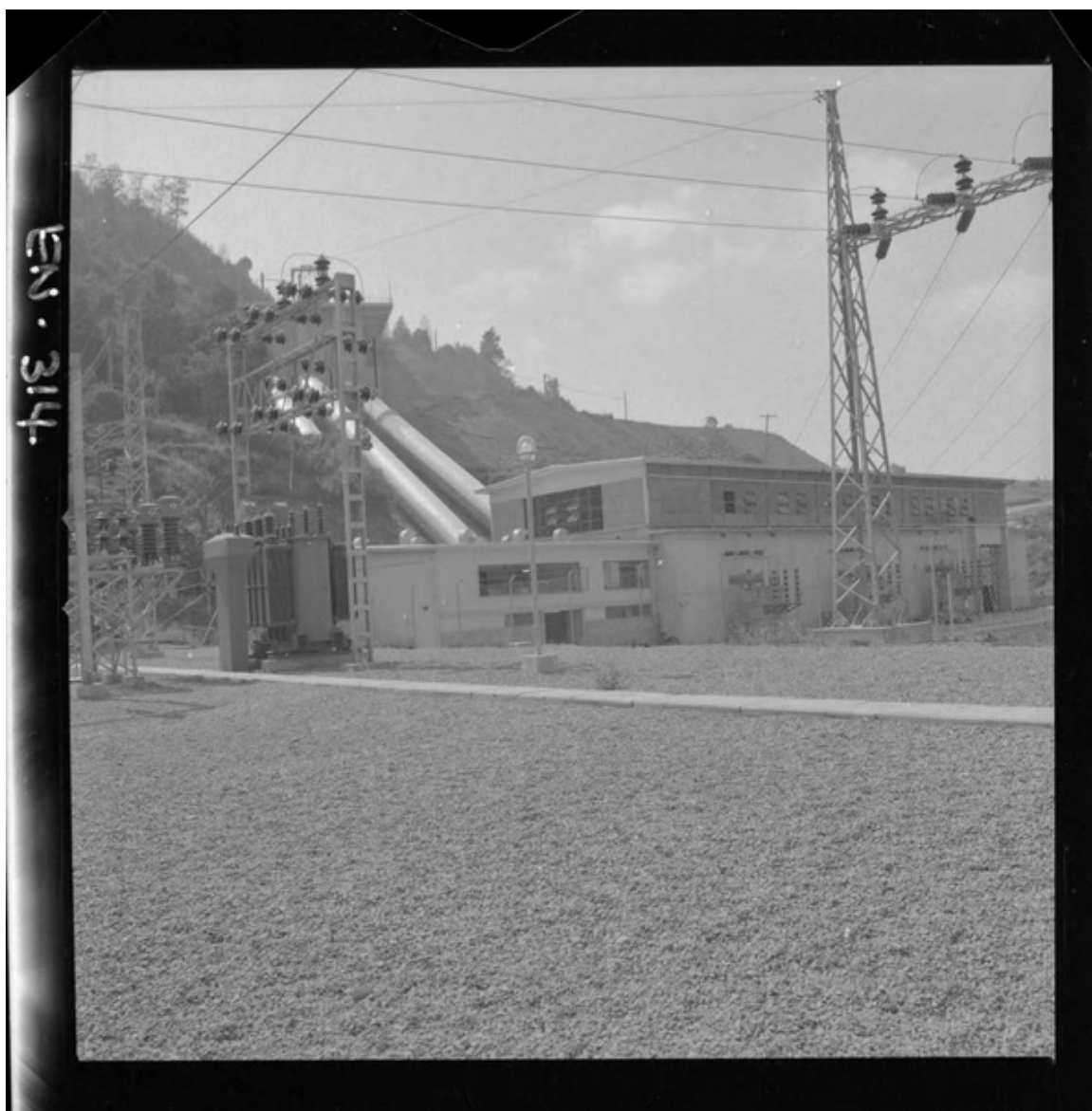
Central Hidroeléctrica "Pullinque"] [fotografía] Luis Ladrón de Guevara.
