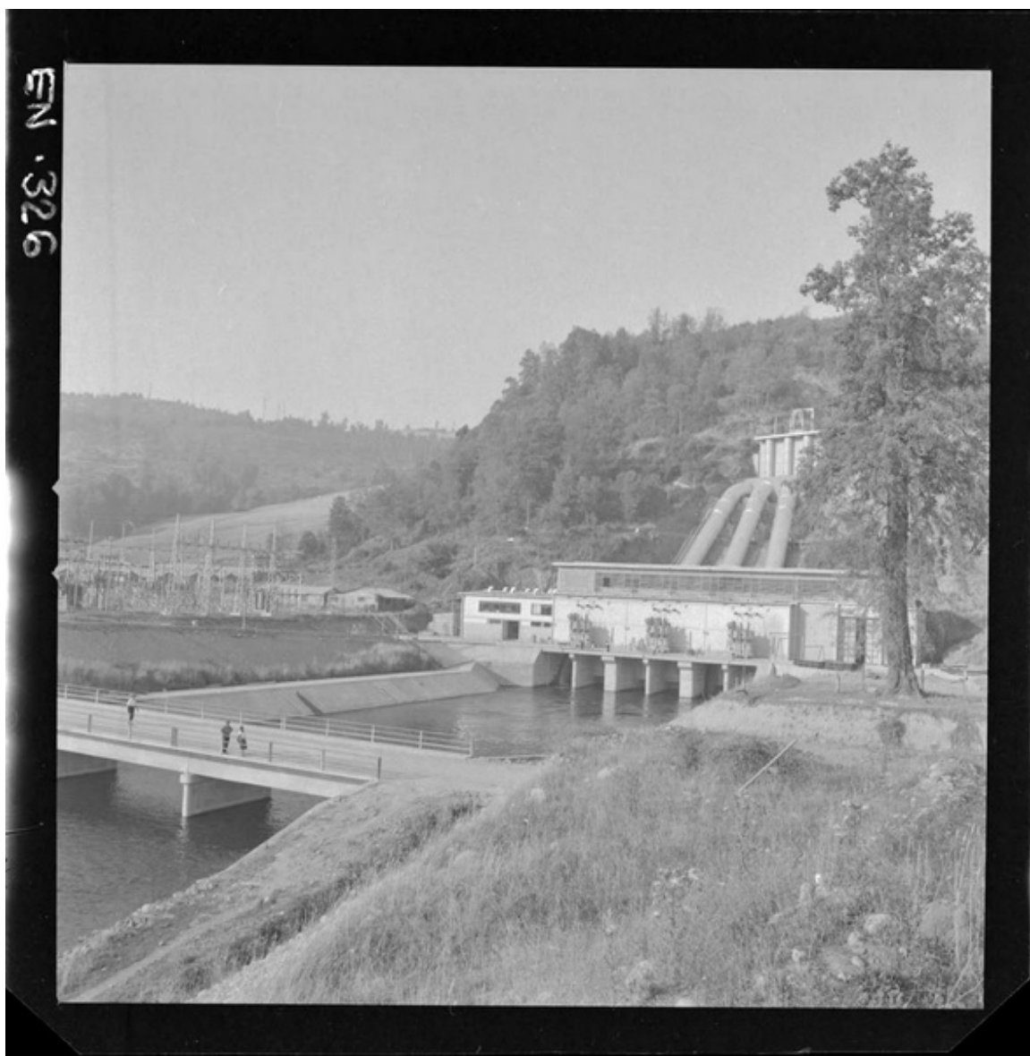
[Central Hidroeléctrica "Pullinque": cámara de carga, tuberías y casa de máquinas] [fotografía] Luis Ladrón de Guevara.
