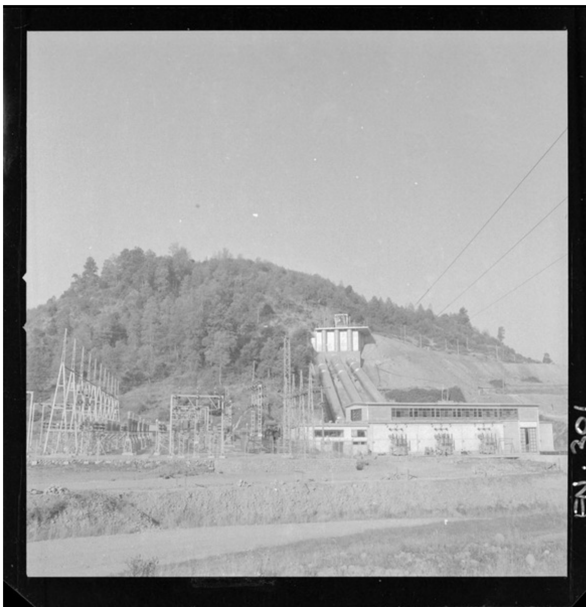
[Panorámica, Central Hidroeléctrica "Pullinque"] [fotografía] Luis Ladrón de Guevara.
