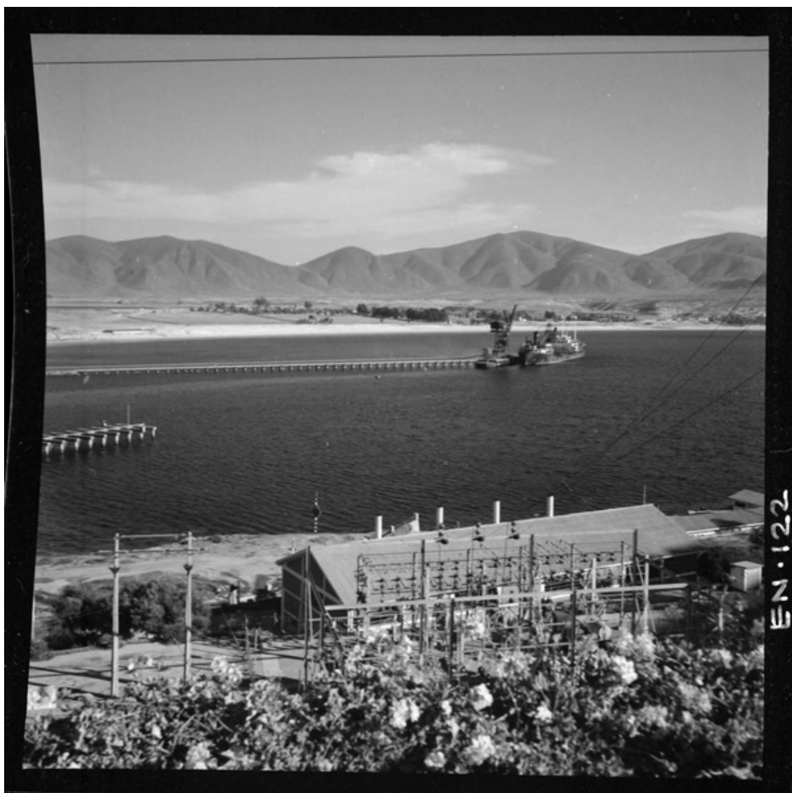
[Central Diesel Eléctrica Guayacán] [fotografía] Luis Ladrón de Guevara.
