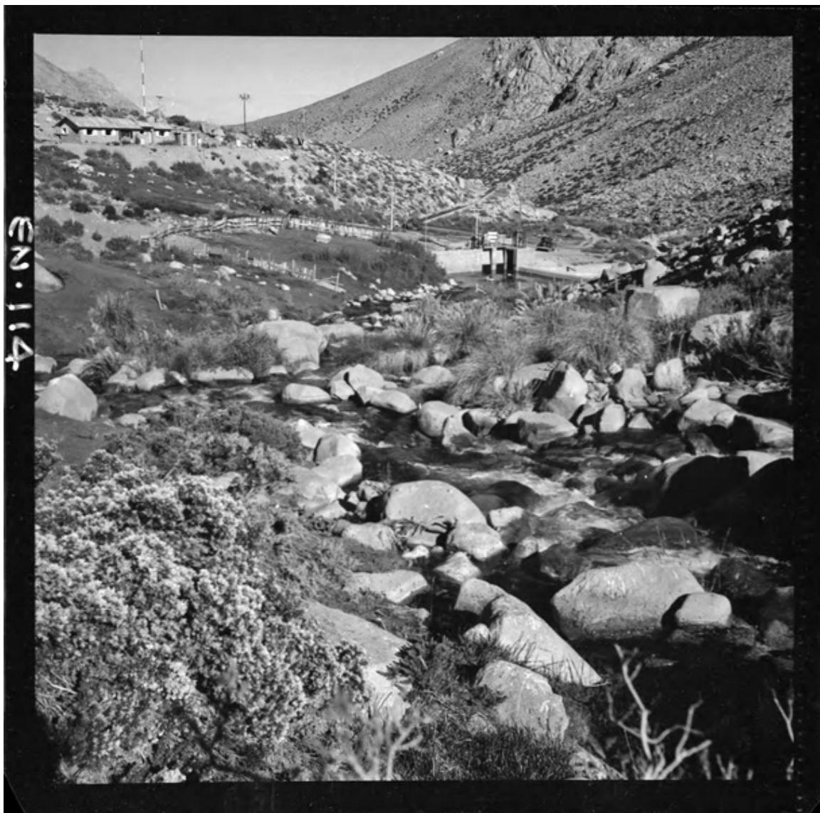
**Bocatoma ubicada a 2600 m. sobre el nivel del mar : capta el agua del río Los Molles y mediante dos compuertas la entrega al canal de aducción. Este discurre cubierto por 17**
