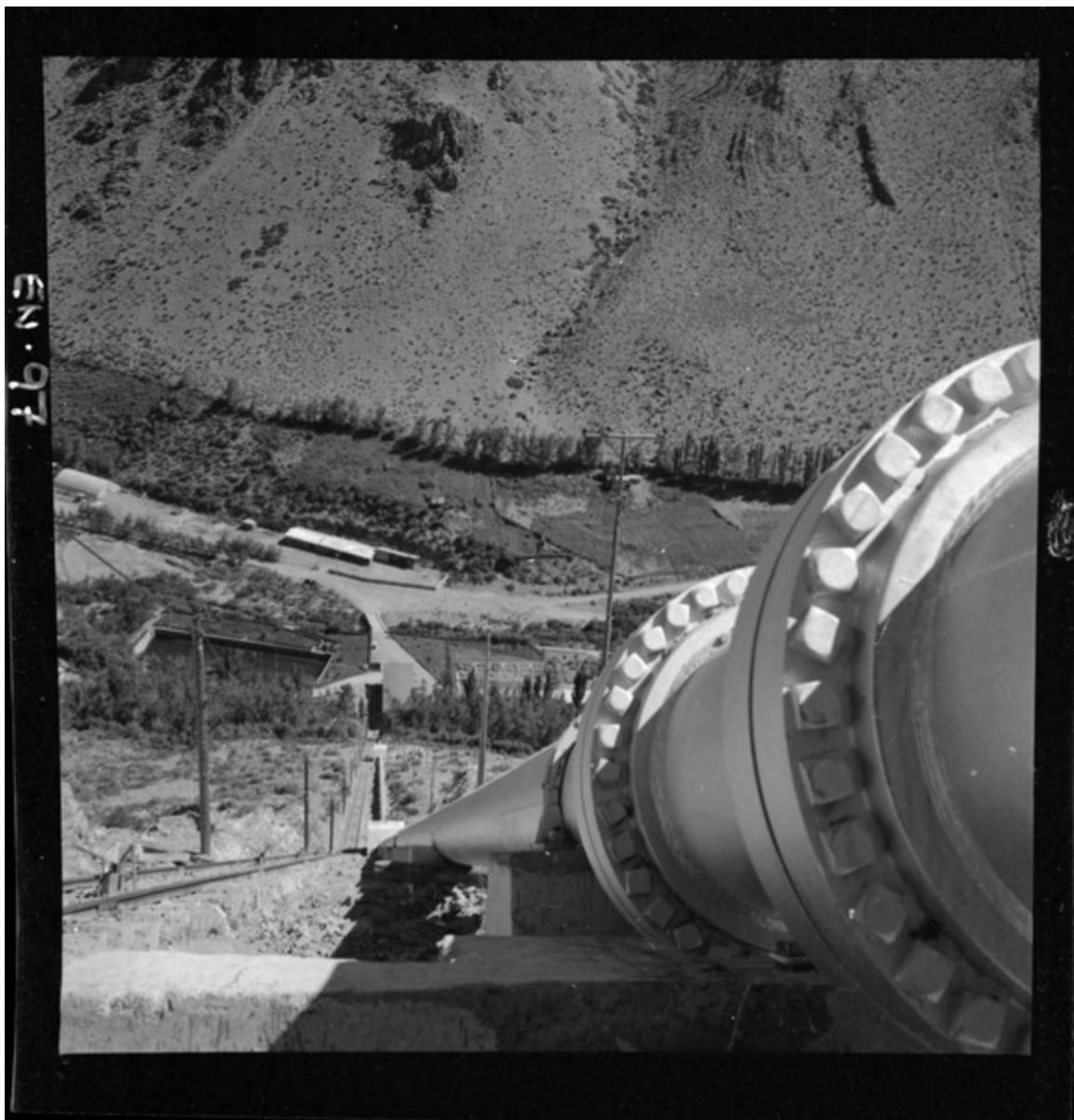
**[Funicular para montaje y mantenimiento junto a la tubería de presión. Es uno de los más largos y de gran desnivel]**
