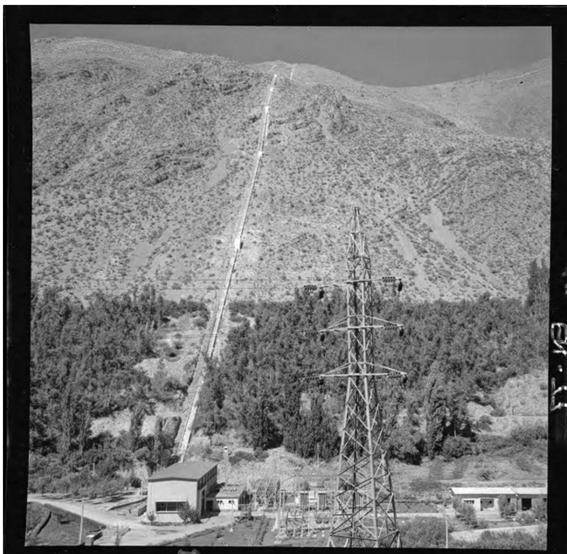
[Patio de alta tensión junto a la casa de máquinas] [fotografía] Luis Ladrón de Guevara.
