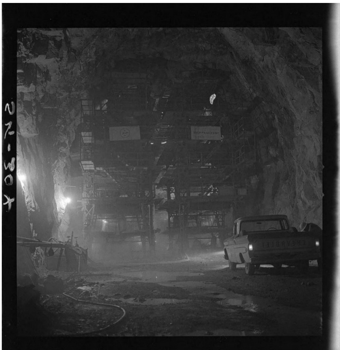
[Refuerzos de la obra de toma, del túnel común de aducción y faenas de hormigonado] [fotografía] Luis Ladrón de Guevara.
