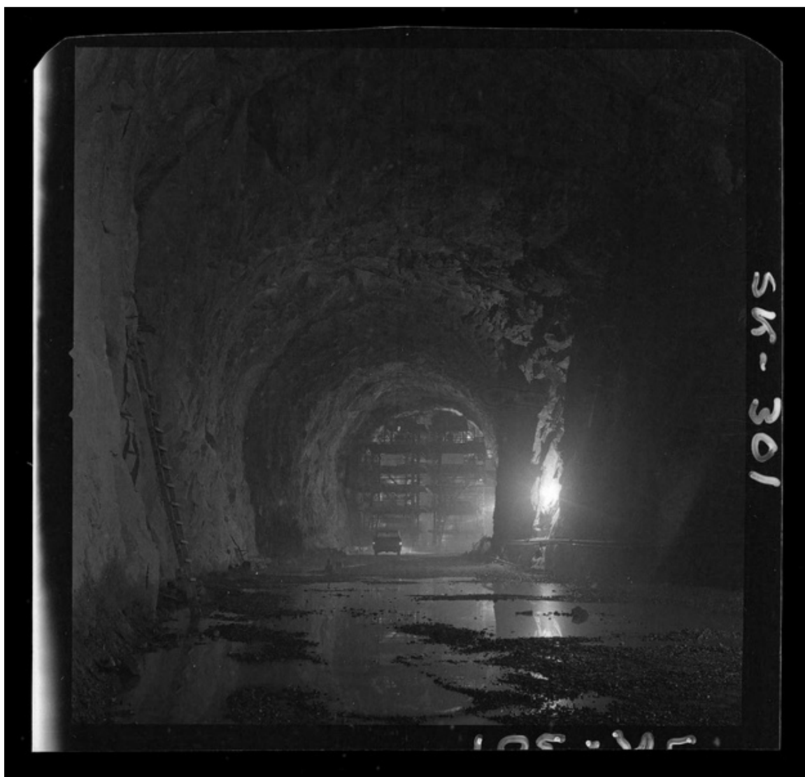
[Refuerzos de la obra de toma, entrada del túnel común de aducción] [fotografía] Luis Ladrón de Guevara.
