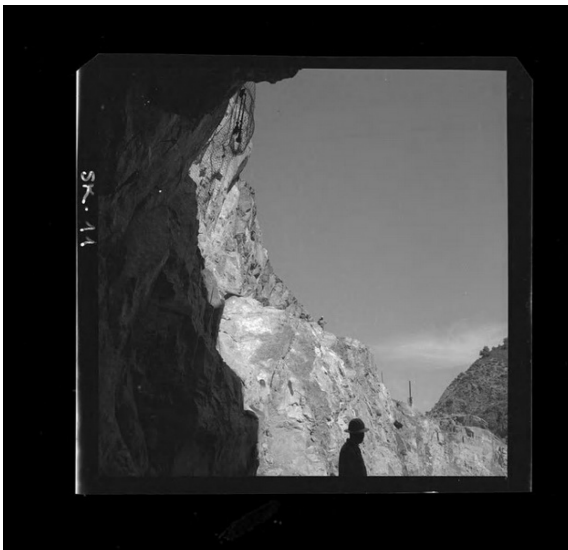
[Construcción Central Hidroeléctrica "Rapel"] [fotografía] Luis Ladrón de Guevara.
