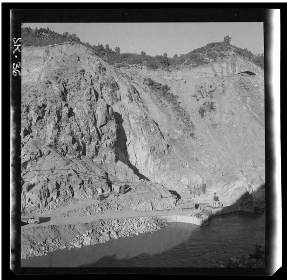
[Construcción de la entrada del túnel común de aducción] [fotografía] Luis Ladrón de Guevara.
