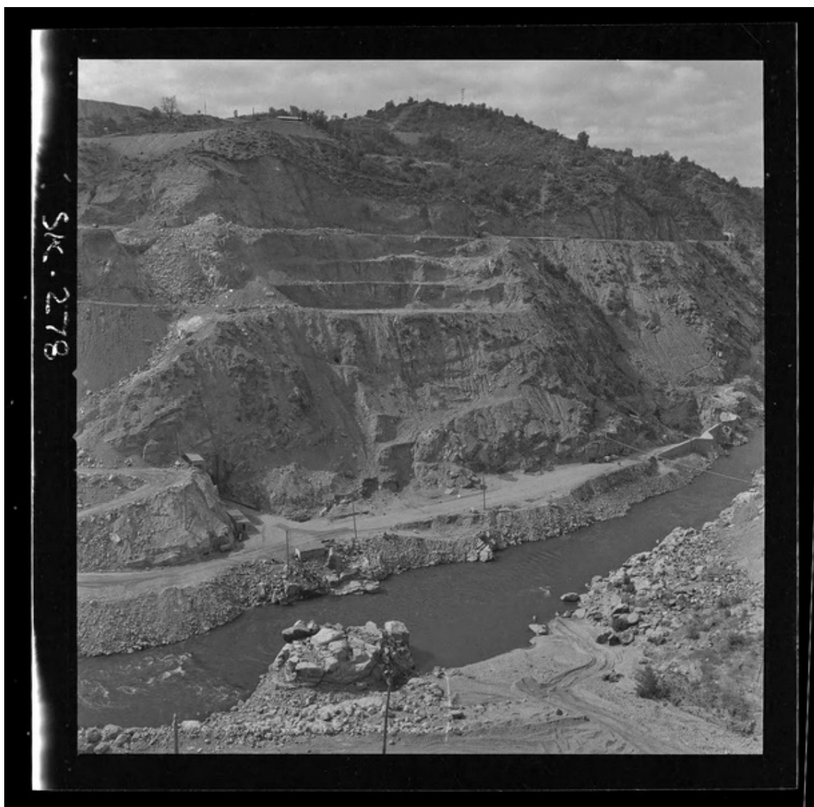
[Construcción Central Hidroeléctrica "Rapel"] [fotografía] Luis Ladrón de Guevara.
