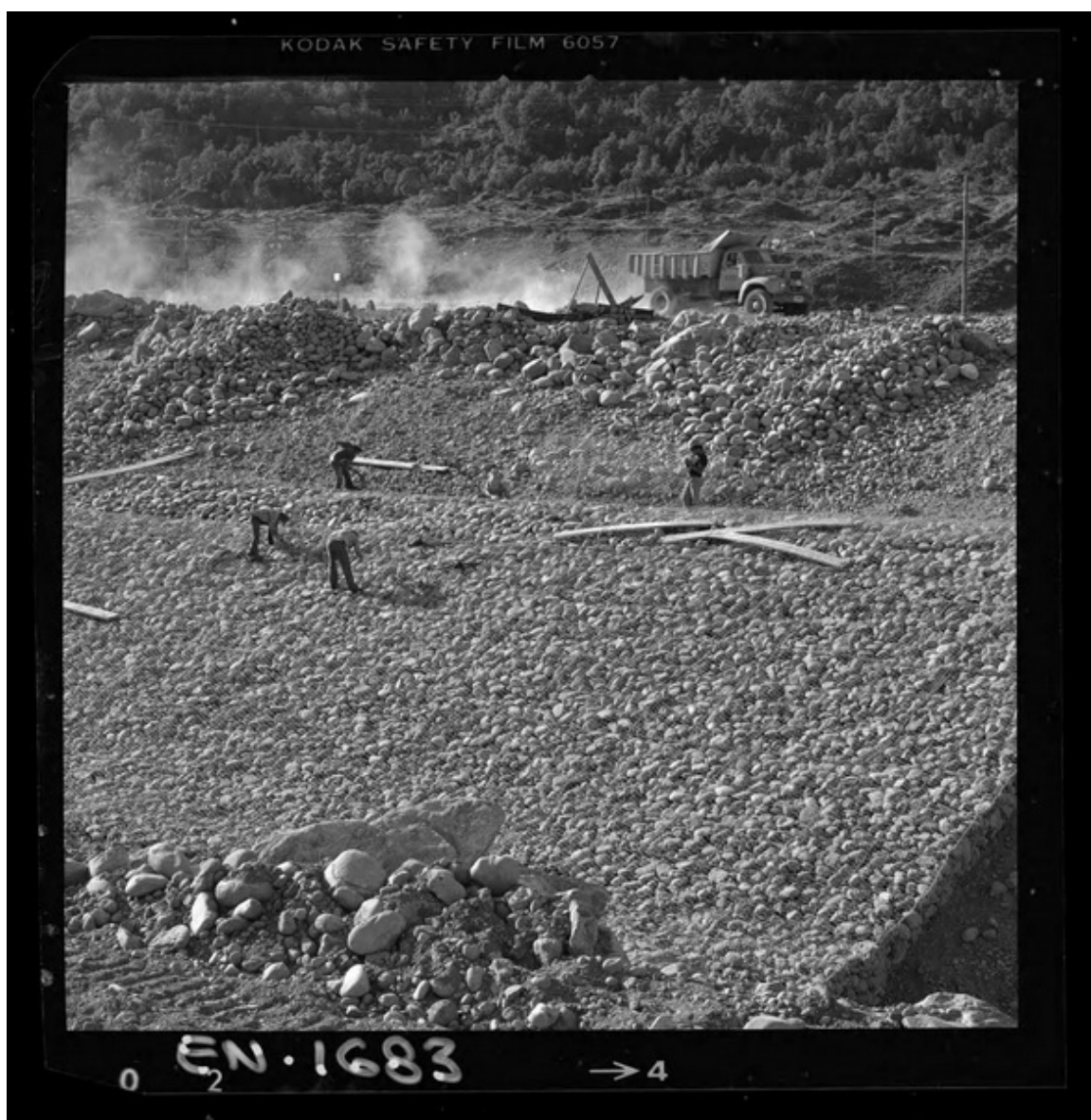
[Casa de máquinas en una segunda etapa : Defensas en el río Laja, protege el patio de alta tensión contiguo a la casa de máquinas] [fotografía] Luis Ladrón de Guevara.
