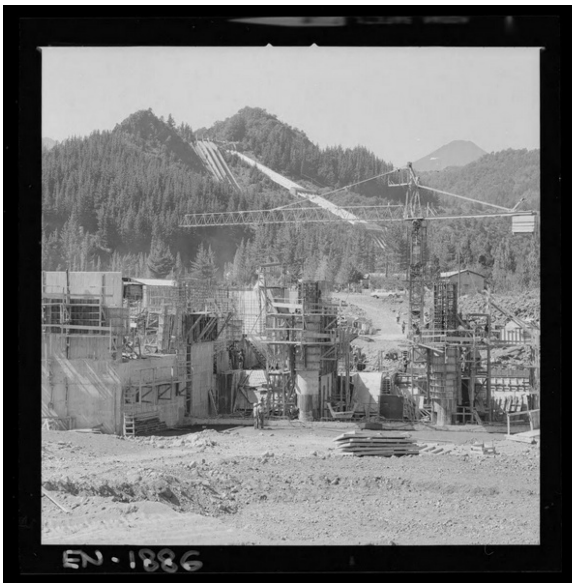
[Casa de máquinas en una segunda etapa : Construcción de bocatomas para aguas de riego provenientes de las Centrales "Antuco" y "Abanico"] [fotografía] Luis Ladrón de
