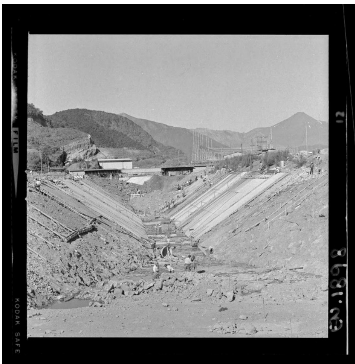
[Casa de máquinas en una segunda etapa : construcción del canal de evacuación] [fotografía] Luis Ladrón de Guevara.
