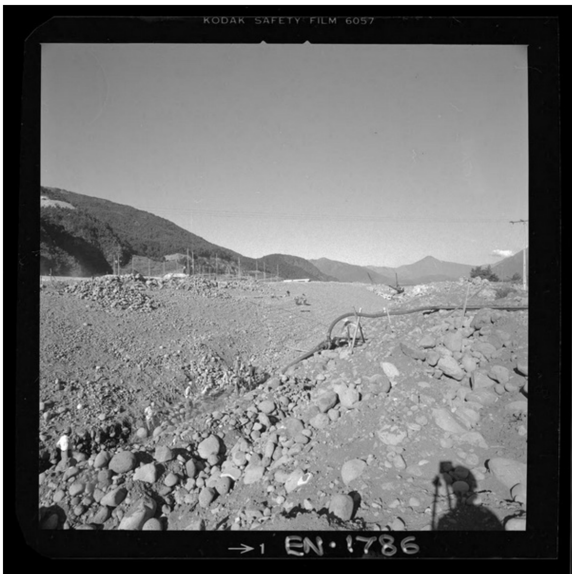
[Casa de máquinas en una segunda etapa : Defensas en el río Laja, protege el patio de alta tensión contiguo a la casa de máquinas] [fotografía] Luis Ladrón de Guevara.
