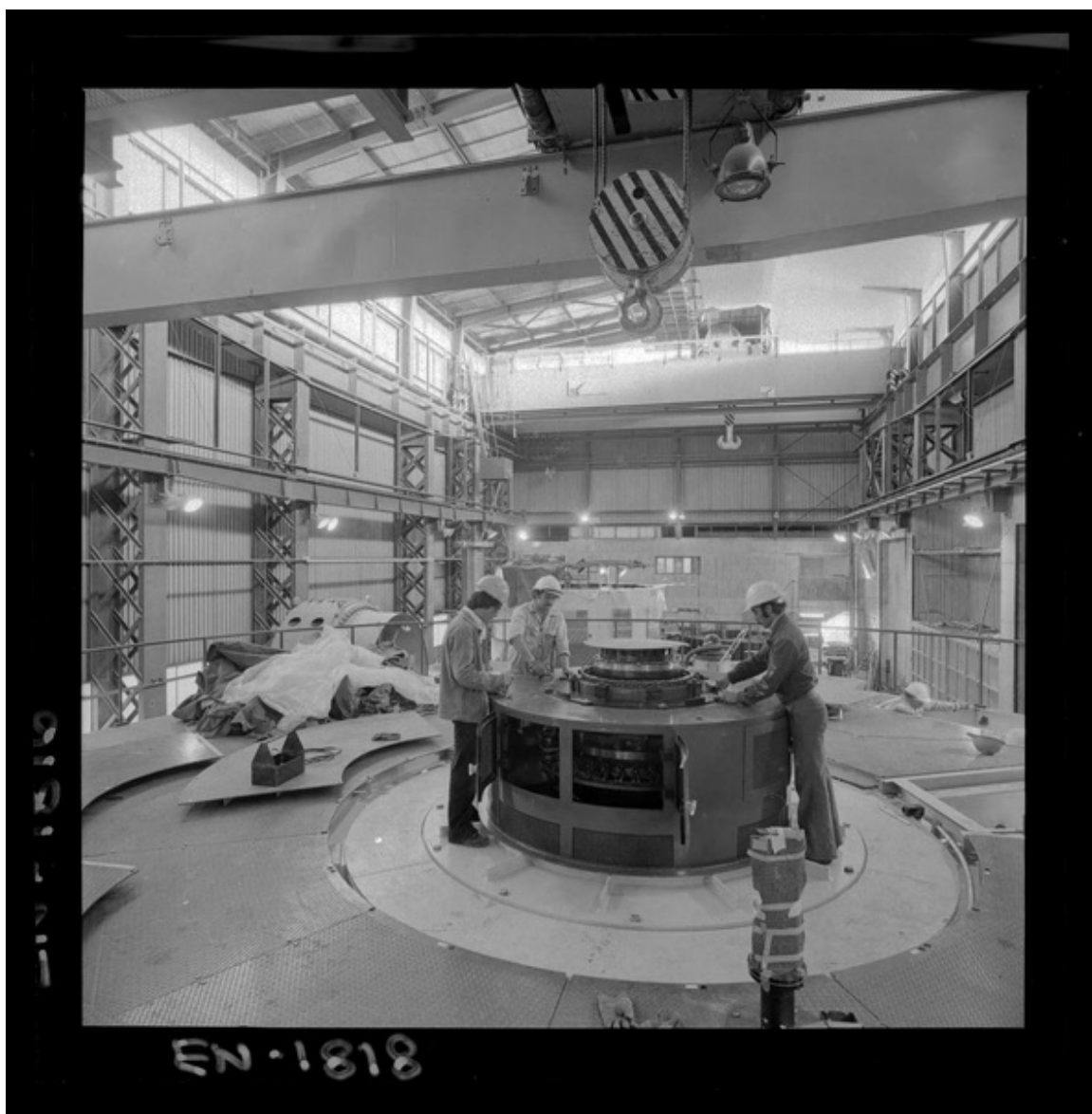
[Casa de máquinas en una segunda etapa : montaje del generador] [fotografía] Luis Ladrón de Guevara.
