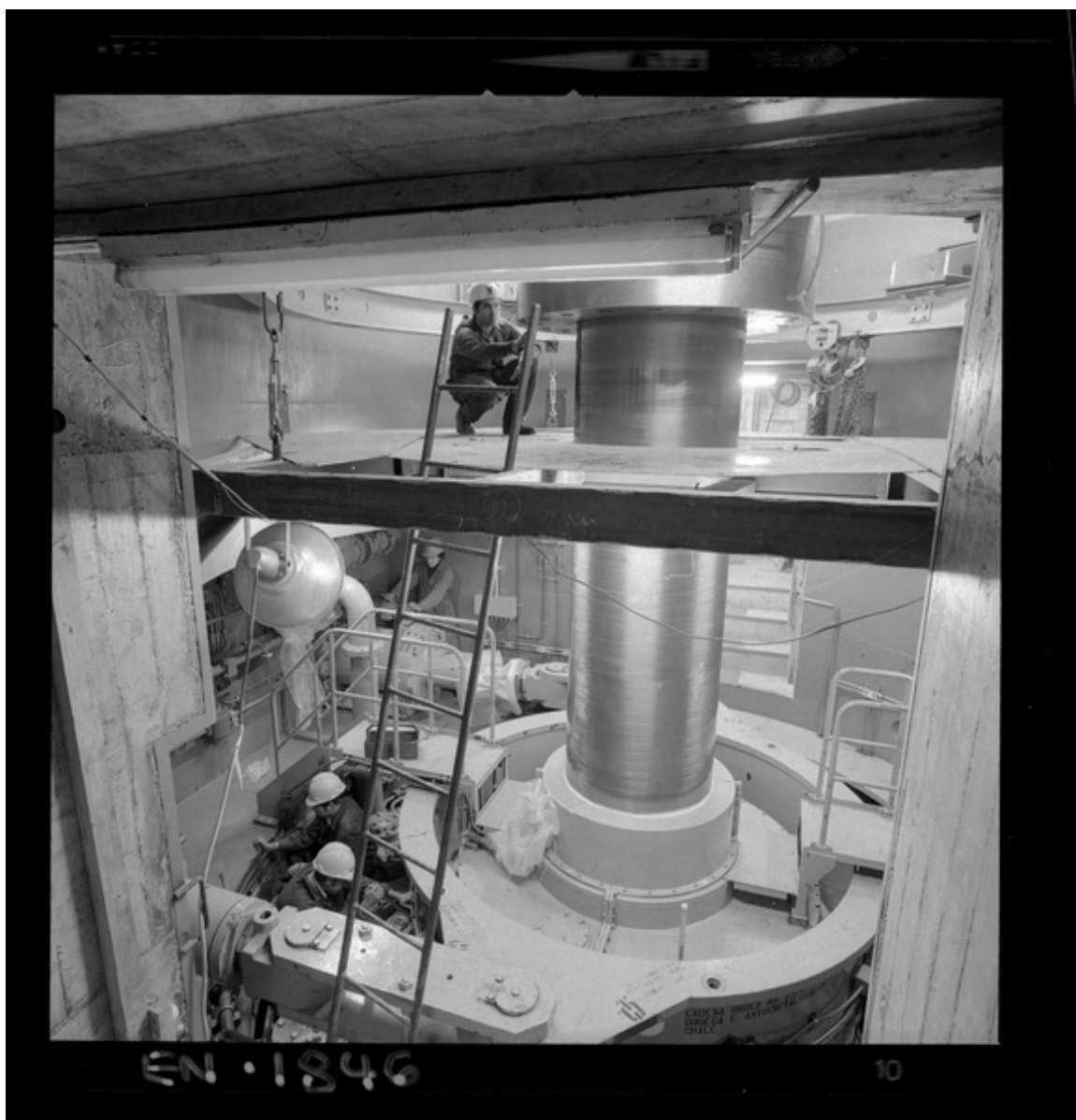
[Casa de máquinas en una segunda etapa : montaje del generador] [fotografía] Luis Ladrón de Guevara.
