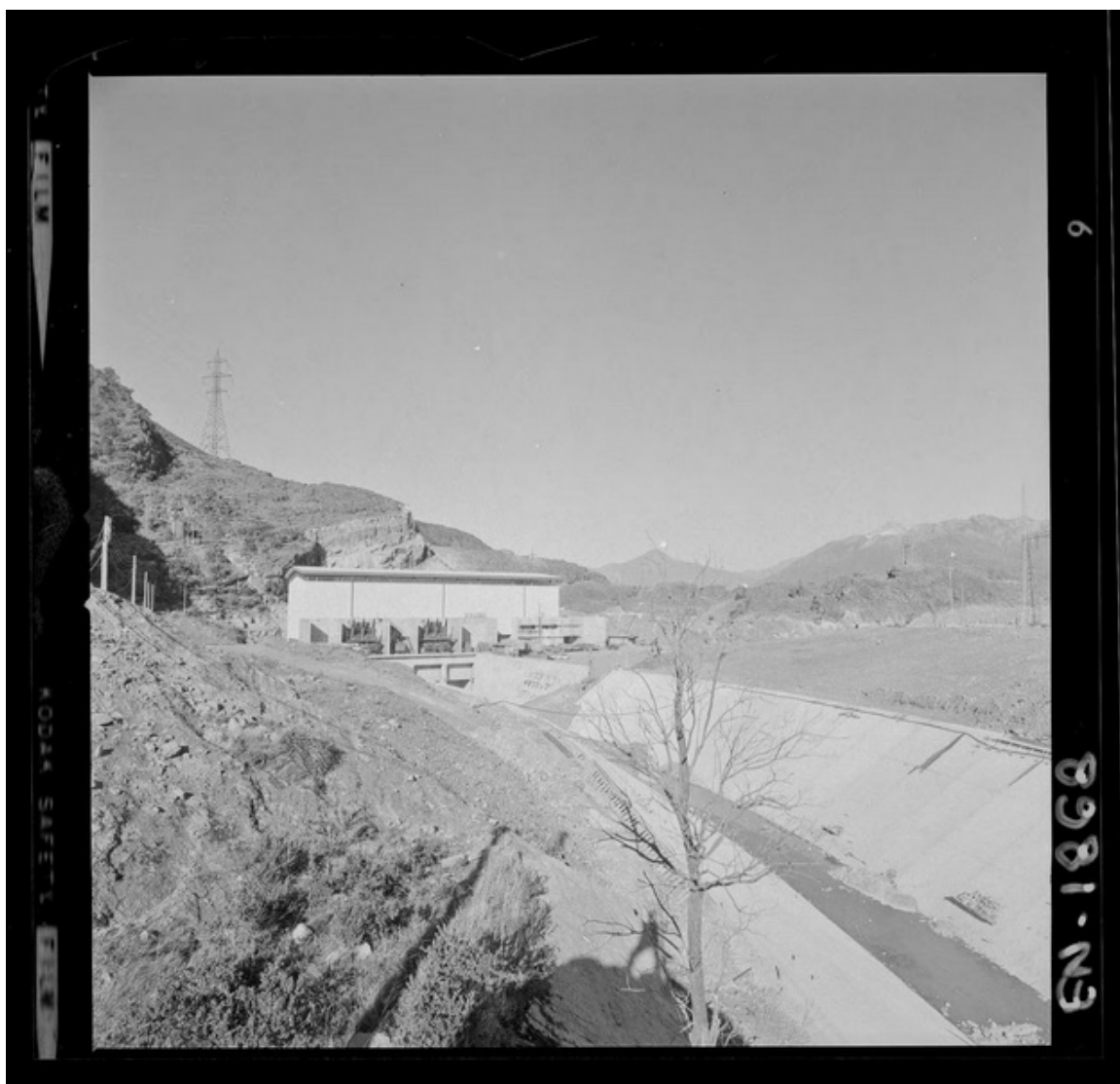
[Etapa de avance de la casa de máquinas, vista exterior] [fotografía] Luis Ladrón de Guevara.
