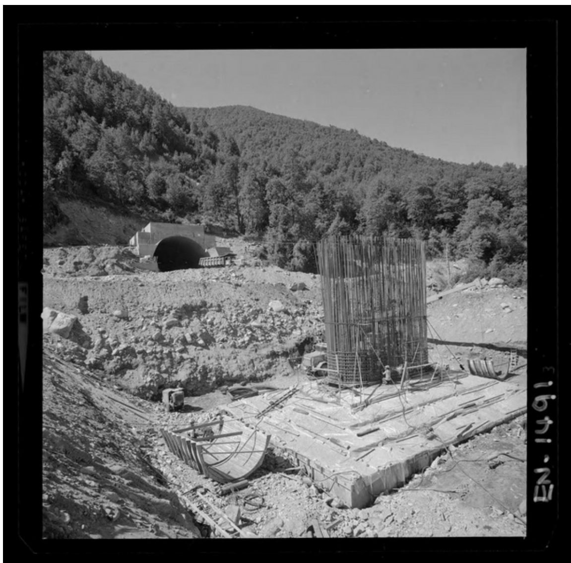
Llegada del túnel de aducción al río Pichipolcura y cepa de apoyo de tubería de acero para el cruce sobre el río [fotografía] Luis Ladrón de Guevara.
