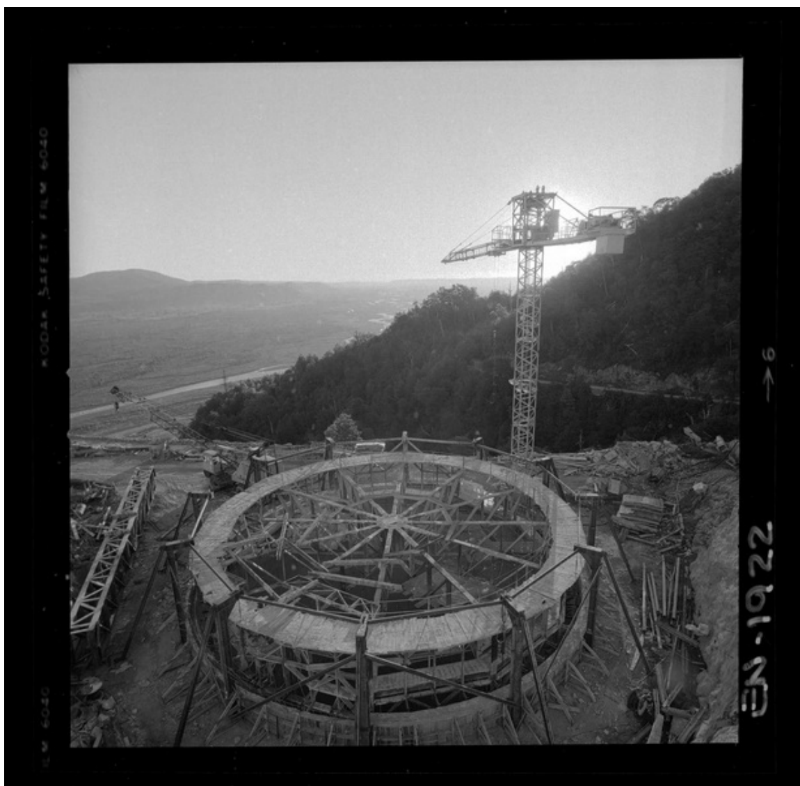
Chimenea de equilibrio, pique vertical de 80 m. de alto y 20 m. de diámetro [fotografía] Luis Ladrón de Guevara.
