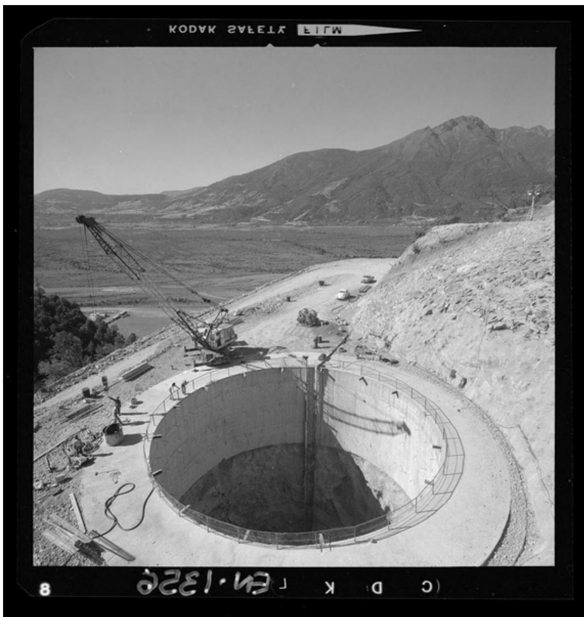
Chimenea de equilibrio, pique vertical de 80 m. de alto y 20 m. de diámetro [fotografía] Luis Ladrón de Guevara.
