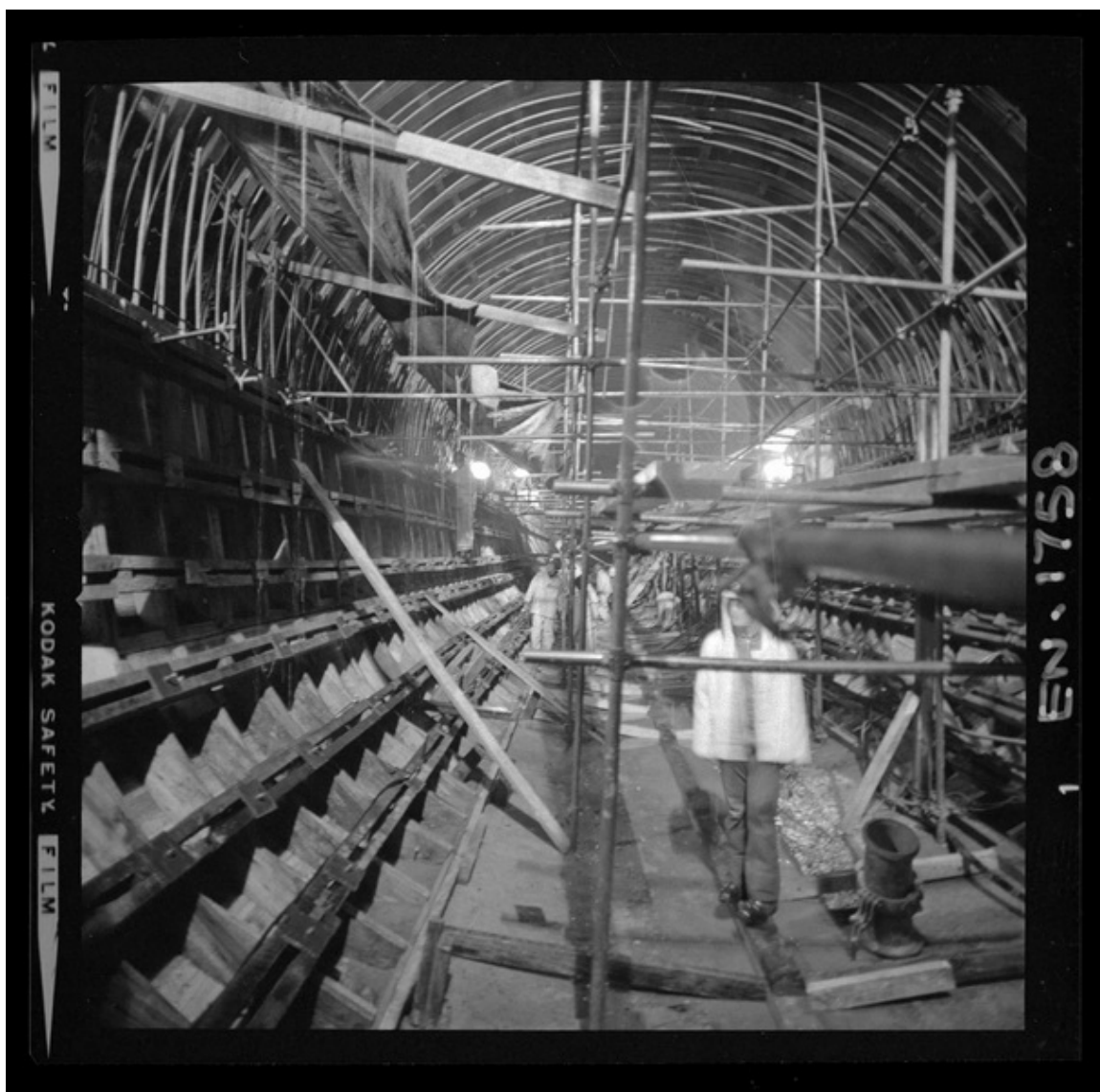
Aspecto de túneles en etapa de terminación, uso de moldajes retráctiles y hormigonado de bóveda [fotografía] Luis Ladrón de Guevara.
