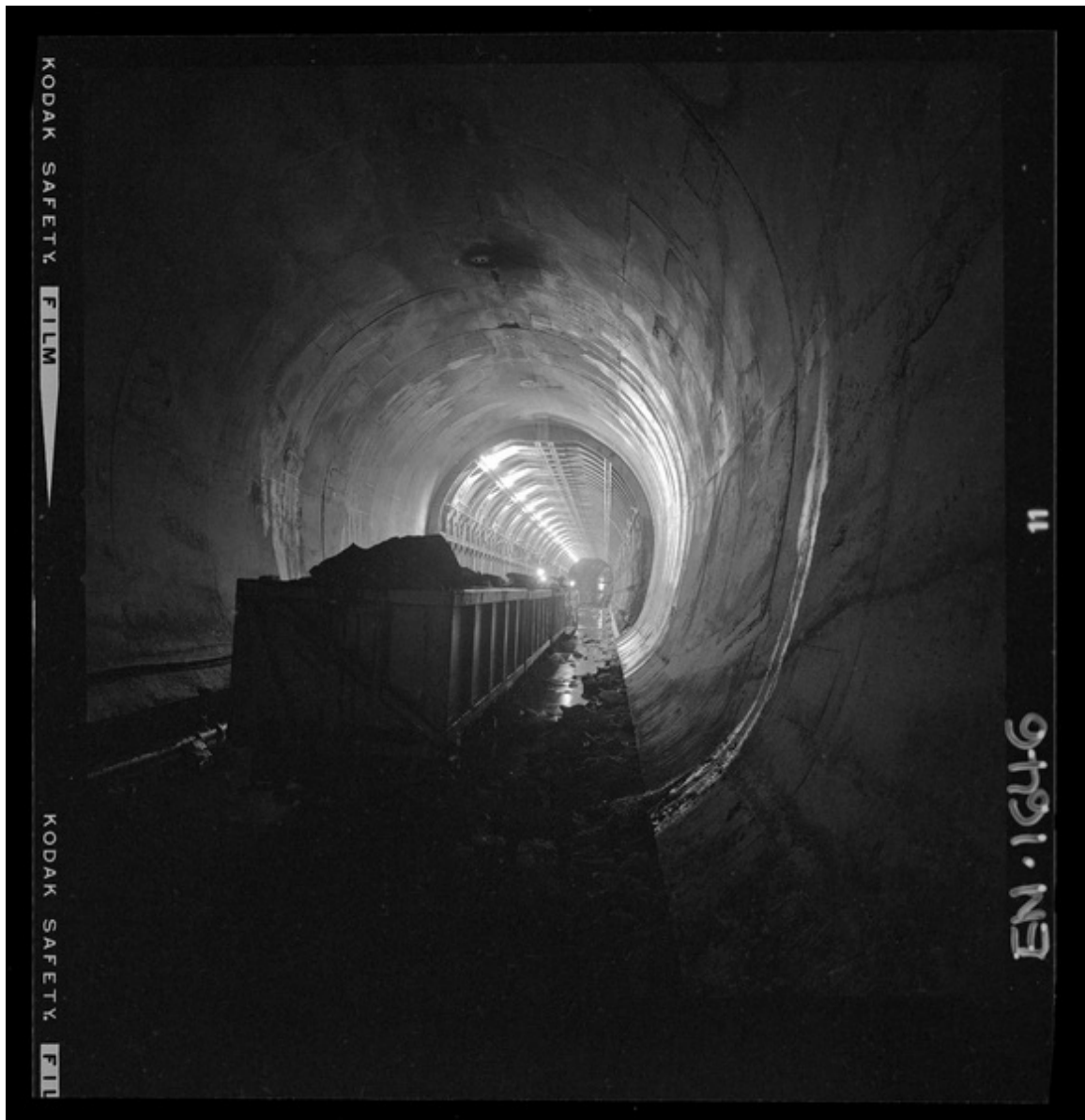
Aspecto de túneles en etapa de terminación, uso de moldajes retráctiles y hormigonado de bóveda [fotografía]
