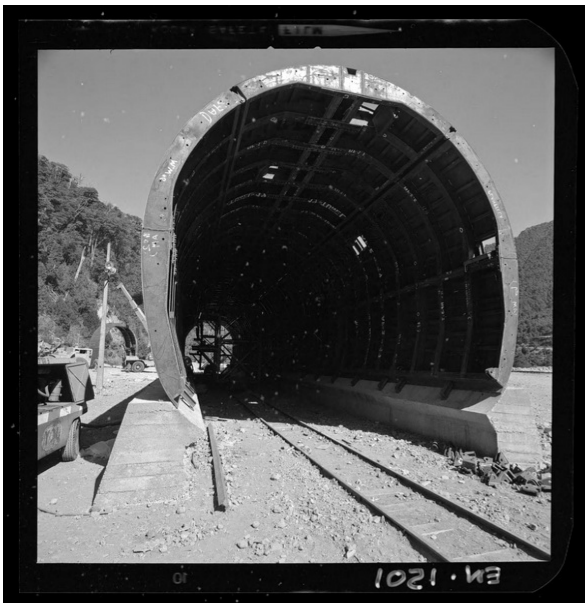
[Construcción de túneles para la Central "Antuco", se contó con equipos especiales] [fotografía] Luis Ladrón de Guevara.
