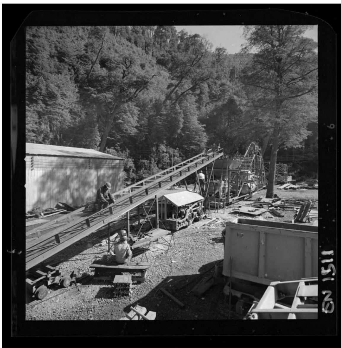
[Construcción de túneles para la Central "Antuco", se contó con equipos especiales] [fotografía] Luis Ladrón de Guevara.
