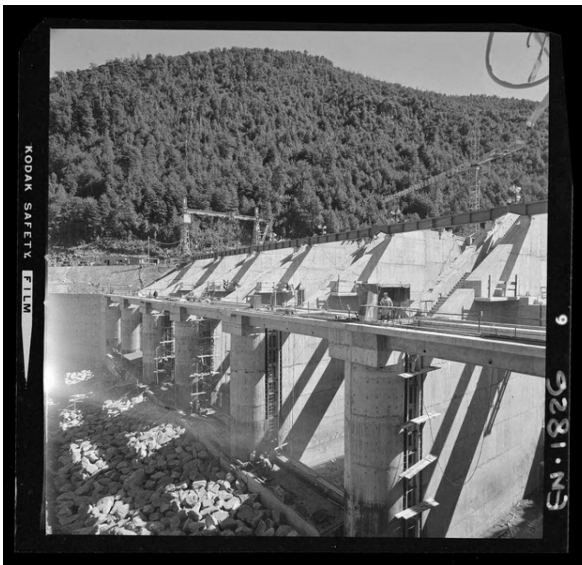
[Río Polcura; vista de las obras de construcción de la bocatoma Polcura, en su última etapa] [fotografía] Luis Ladrón de Guevara.
