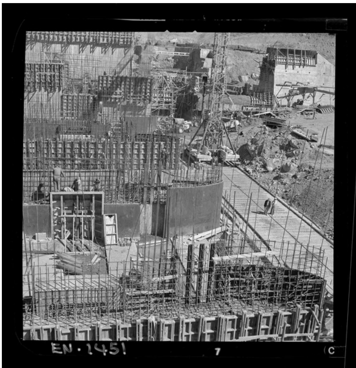
[Río Polcura; vista de las obras de construcción de la bocatoma Polcura] [fotografía] Luis Ladrón de Guevara.
