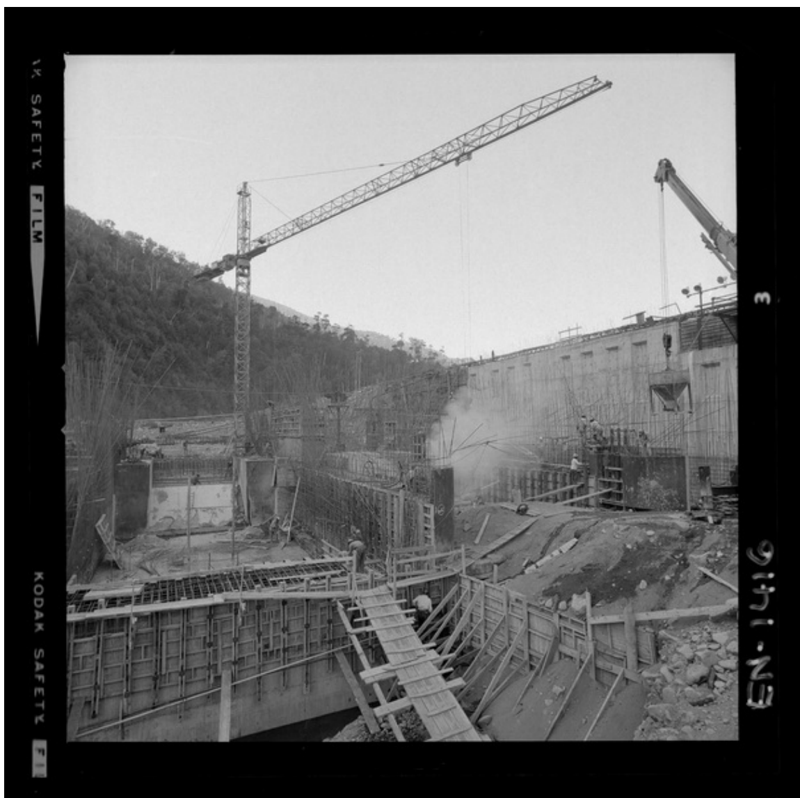
[Río Polcura; vista de las obras de construcción de la bocatoma Polcura] [fotografía] Luis Ladrón de Guevara.
