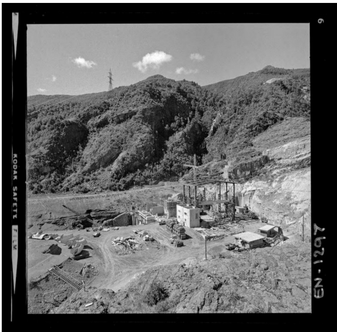
Construcción de la casa de máquinas, se aprecia la salida de dos túneles que alimentarán las turbinas. [fotografía] Luis Ladrón de Guevara.
