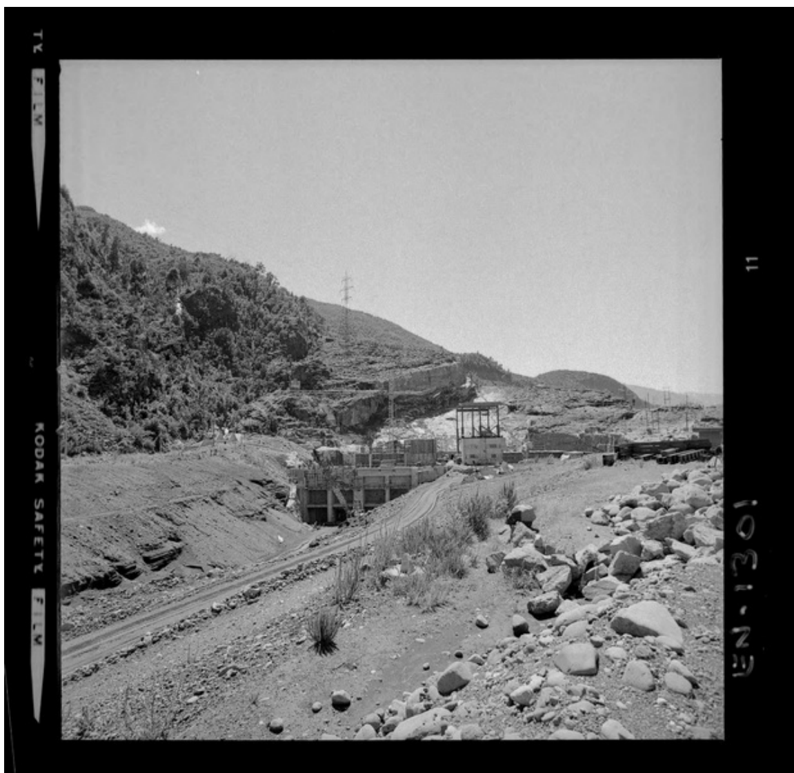
Construcción de la casa de máquinas, se aprecia la salida de dos túneles que alimentarán las turbinas. [fotografía] Luis Ladrón de Guevara.
