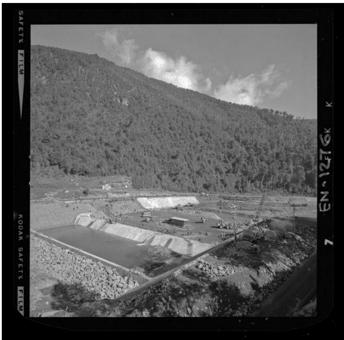
[Río Polcura; vista de las obras de construcción de la bocatoma Polcura : Excavación y hormigones en la barrera móvil] [fotografía] Luis Ladrón de Guevara.
