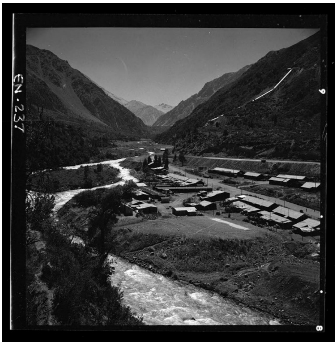
Patio de alta tensión y torres de conducción [fotografía] Luis Ladrón de Guevara.
