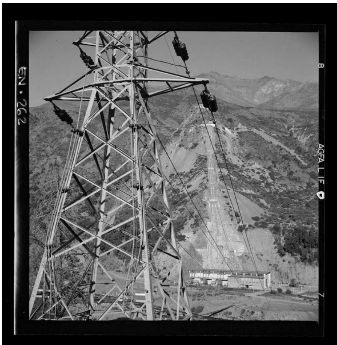
[Desarrollo de las tuberías desde la chimenea de equilibrio hasta la Central "Cipreses"; ambiente en que predominan los cipreses] [fotografía] Luis Ladrón de Guevara.
