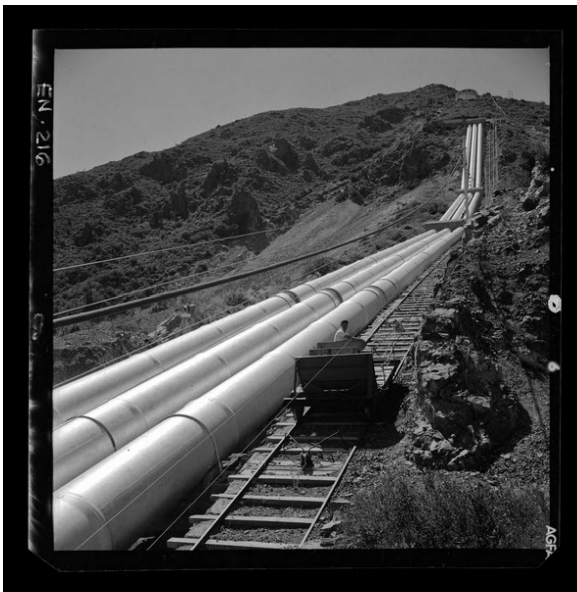
[Carro de arrastre, corre paralelo a tres tuberías de acero, lo que facilita el acceso para el servicio y la mantención] [fotografía] Luis Ladrón de Guevara.
