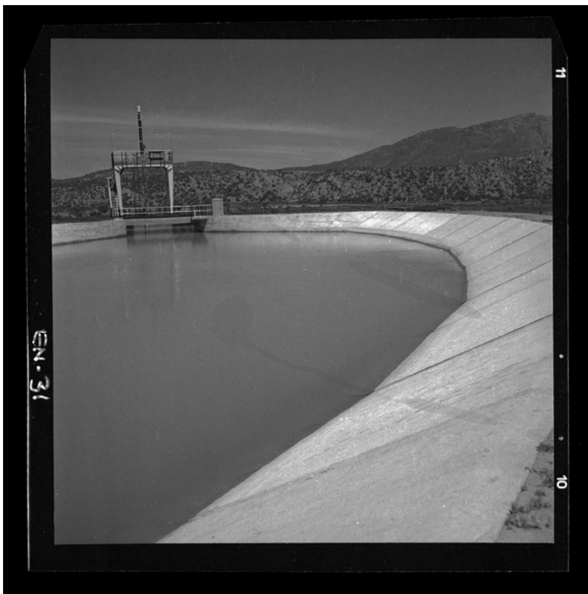
[Cámara de carga, Central Hidroeléctrica "Sauzalito"] [fotografía] Luis Ladrón de Guevara.
