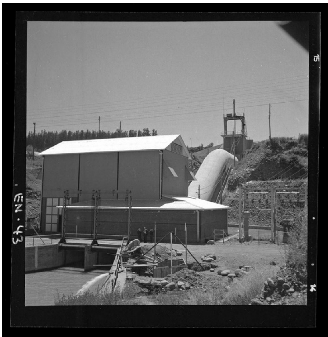
[Central Hidroeléctrica "Sauzalito"] [fotografía] Luis Ladrón de Guevara.
