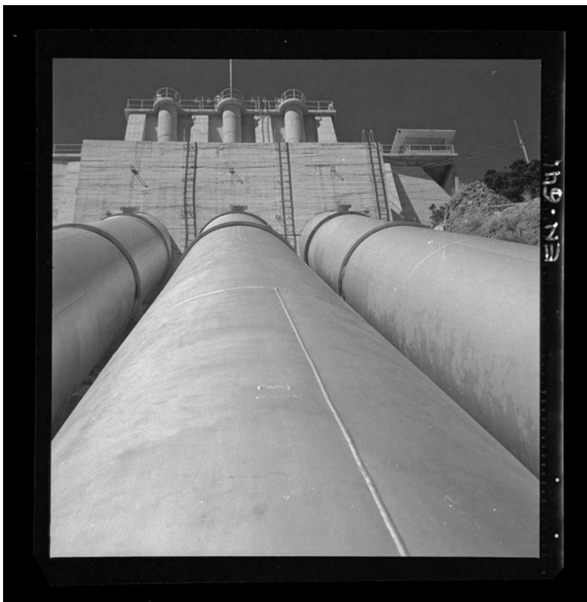
[Vista de 3 cañerías metálicas, conducen el agua de la cámara de carga a la casa de máquinas, descenso casi vertical de 120 m.] [fotografía] Luis Ladrón de Guevara.
