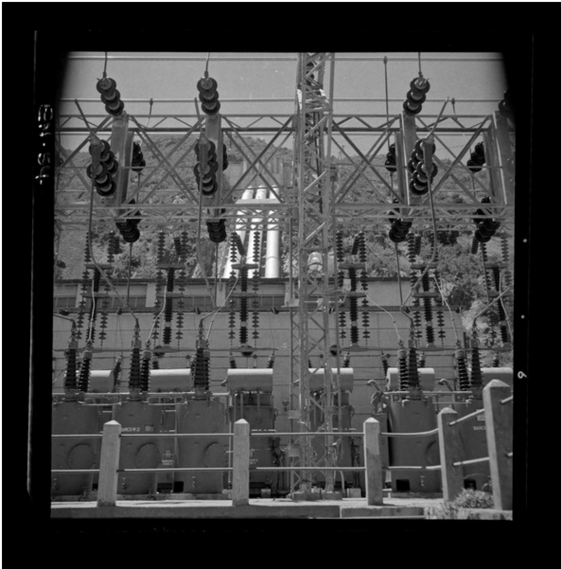
[Central Hidroeléctrica "Sauzal"] [fotografía] Luis Ladrón de Guevara.
