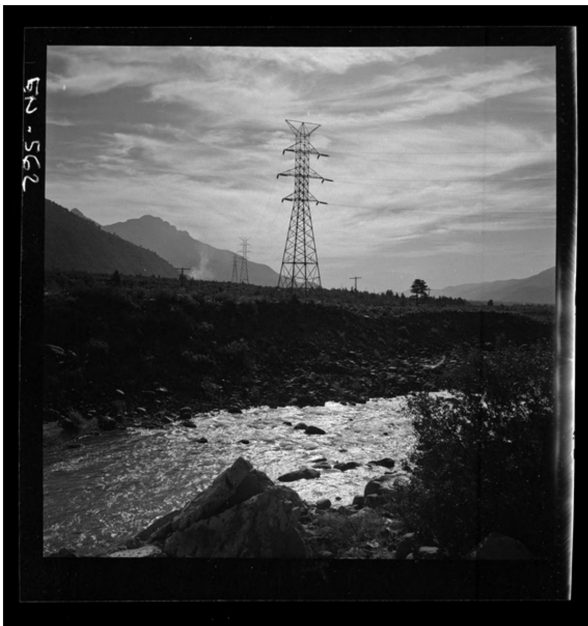
[Torre de conducción junto al río Laja] [fotografía] Luis Ladrón de Guevara.
