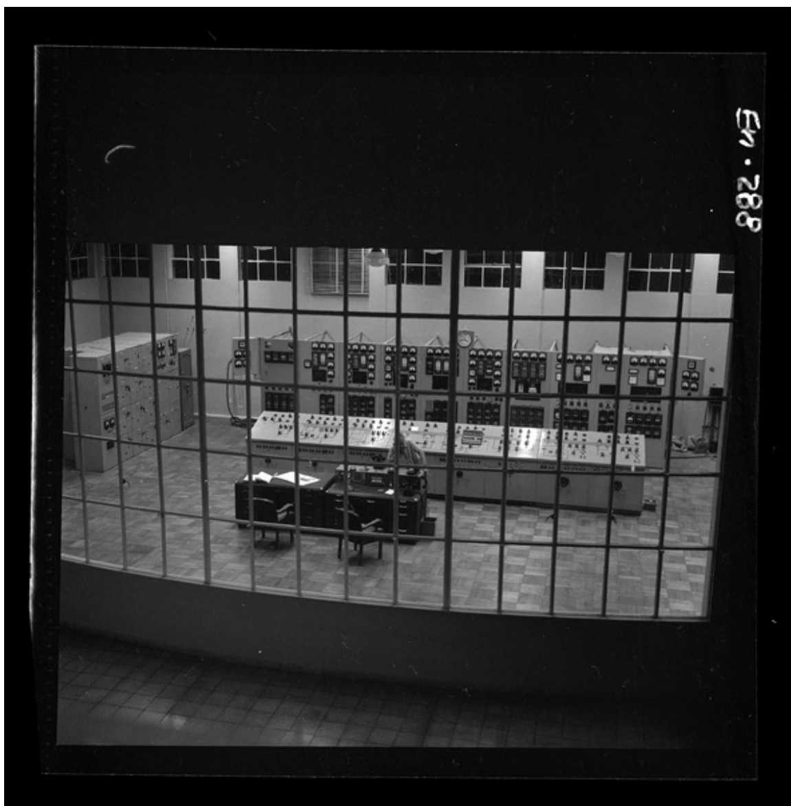
Paneles de control de la Central [fotografía] Luis Ladrón de Guevara.
