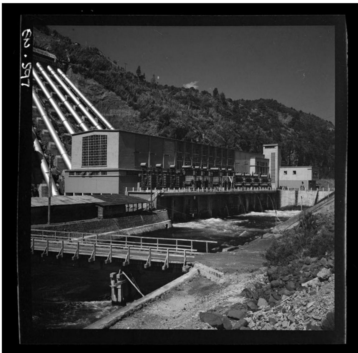
Vista de la Central desde el canal de evacuación [fotografía] Luis Ladrón de Guevara.
