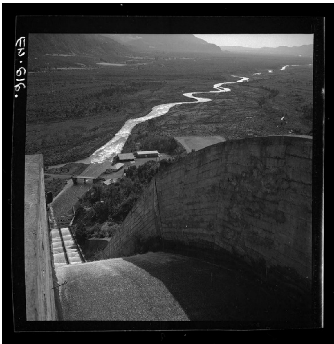
[Detalle de tuberías y Rápido de Descarga (obras de seguridad) con vista al río Laja] [fotografía] Luis Ladrón de Guevara.
