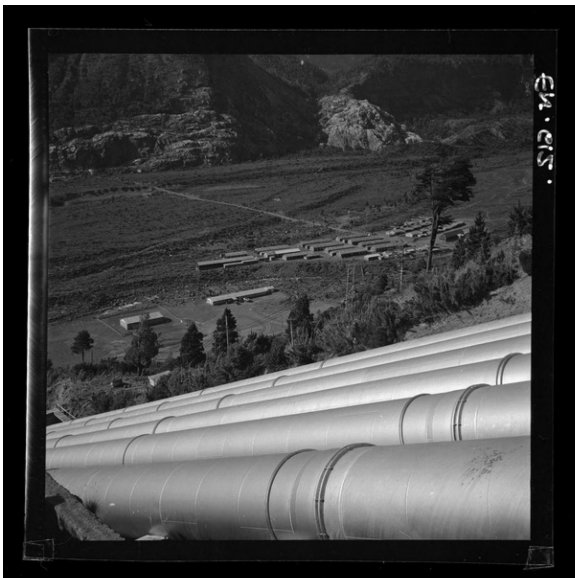
[Detalle de tuberías y Rápido de descarga (obras de seguridad)] [fotografía] Luis Ladrón de Guevara.
