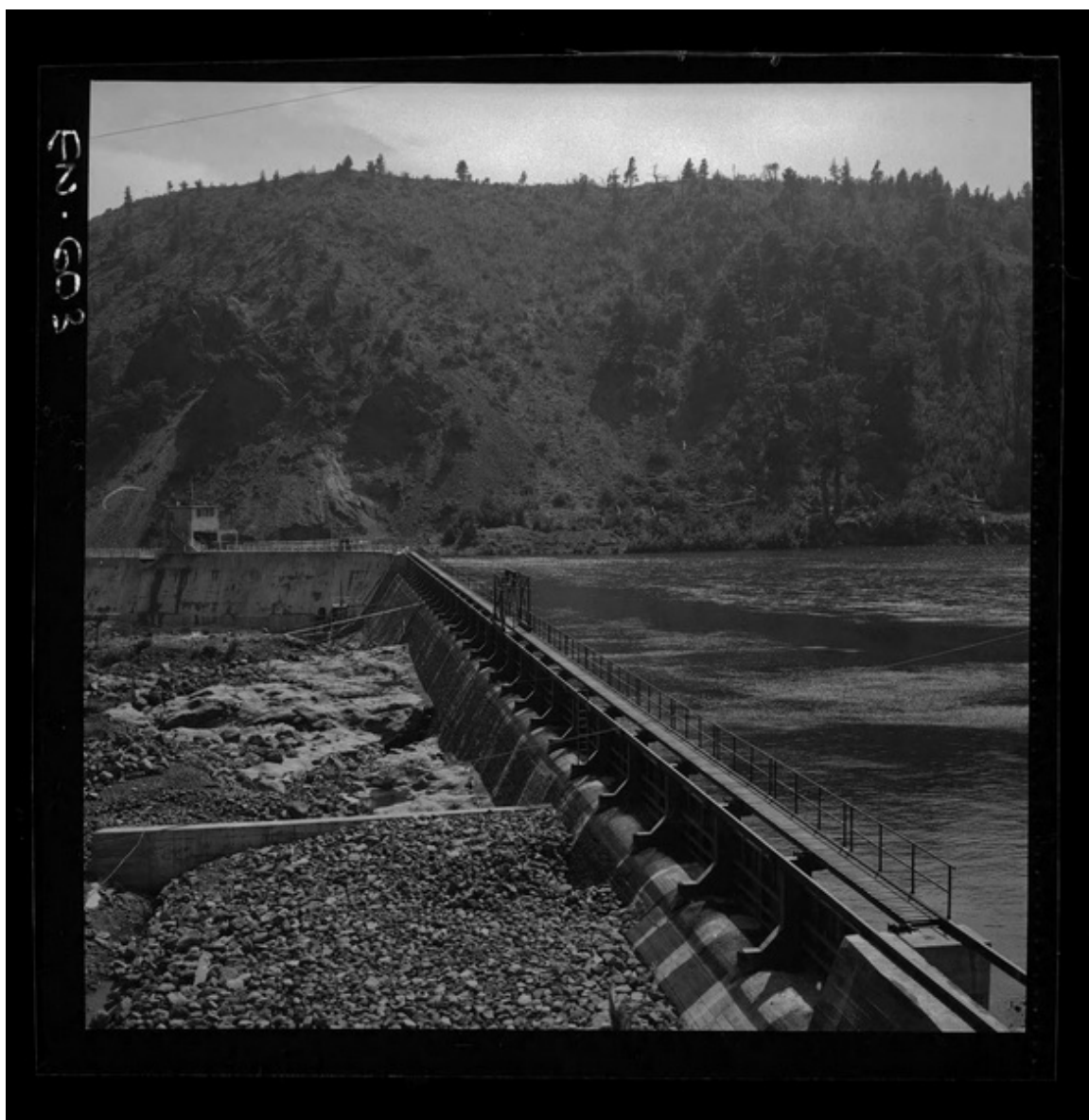
Bocatoma, barrera de 150 m. de largo, provista de compuertas que atajan el río Laja y desvían su caudal hacia el canal de aducción [fotografía] Luis Ladrón de Guevara.
