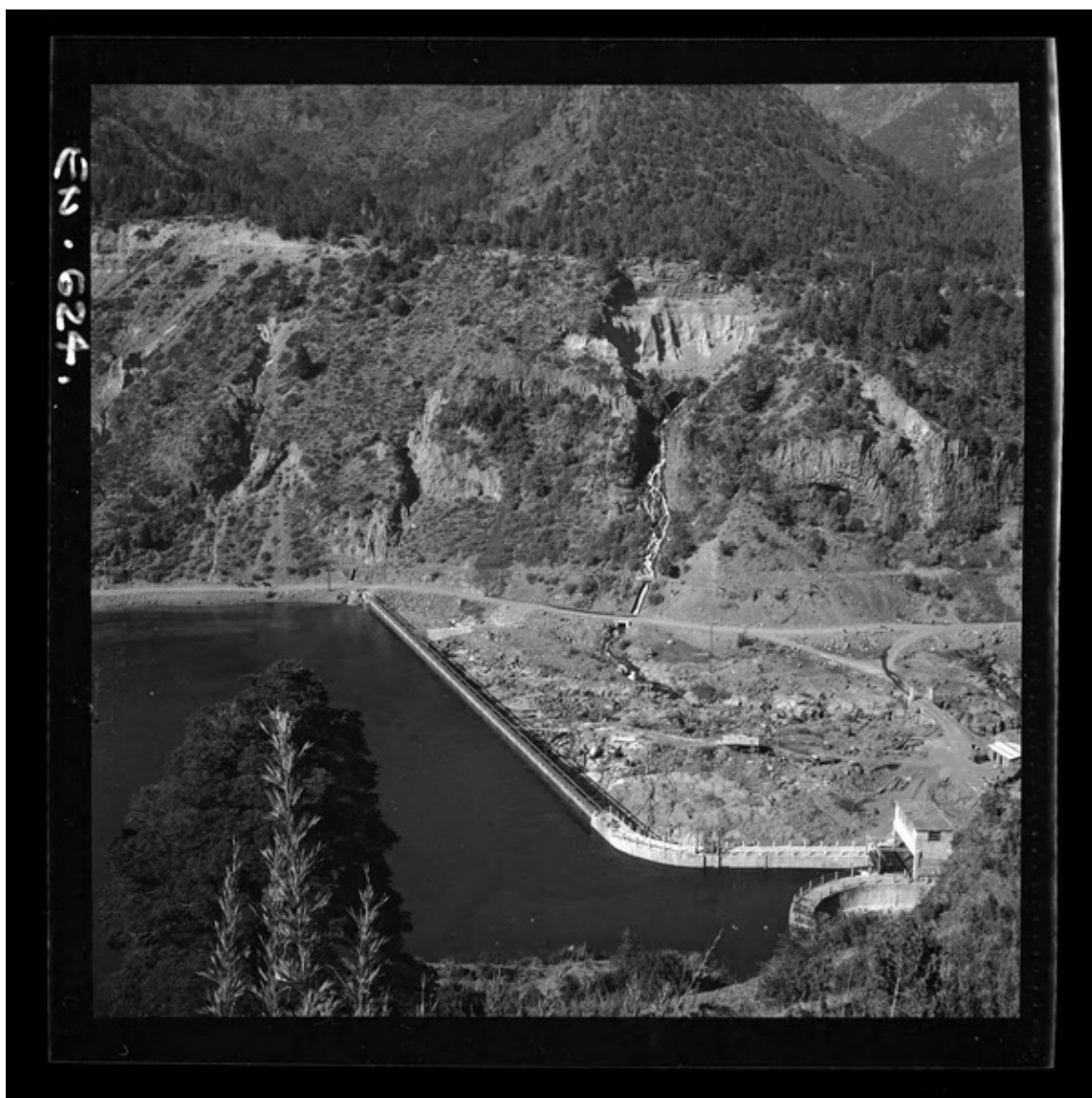
Bocatoma, barrera de 150 m. de largo, provista de compuertas que atajan el río Laja y desvían su caudal hacia el canal de aducción [fotografía] Luis Ladrón de Guevara.
